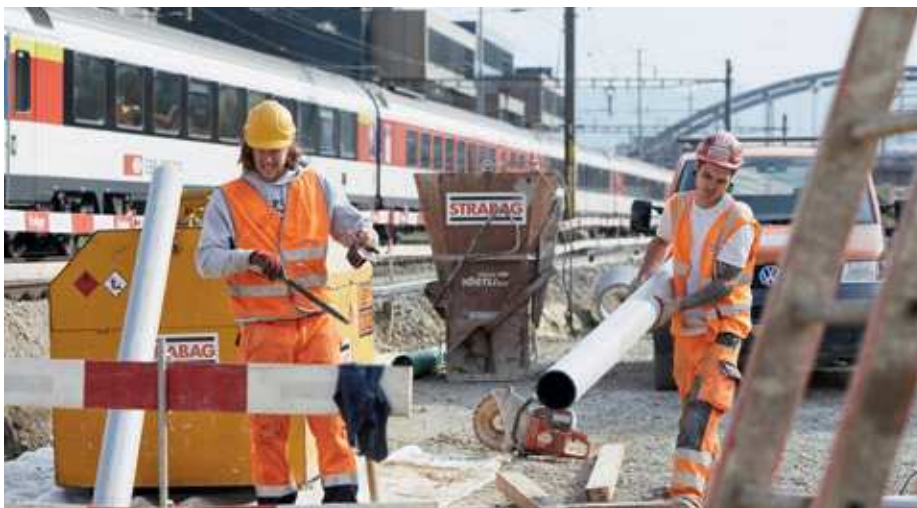
Die Züge fahren verlangsamt weiter: Vorbereitung zur Verlegung neuer Leitungen quer zum Gleisfeld.
