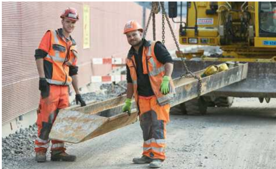
Erste Spuren des neuen Tunnels: Einzelne Spundwände werden herangeschafft.
