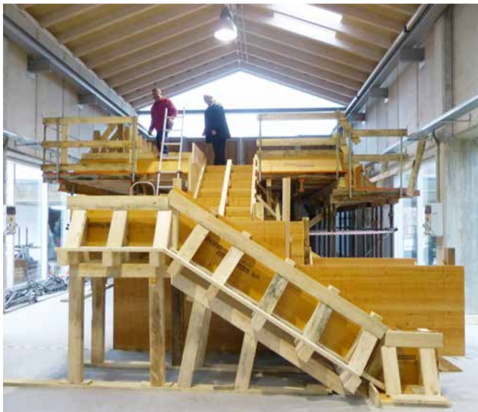
Os formandos realizam exercícios como este na área de cofragens...
