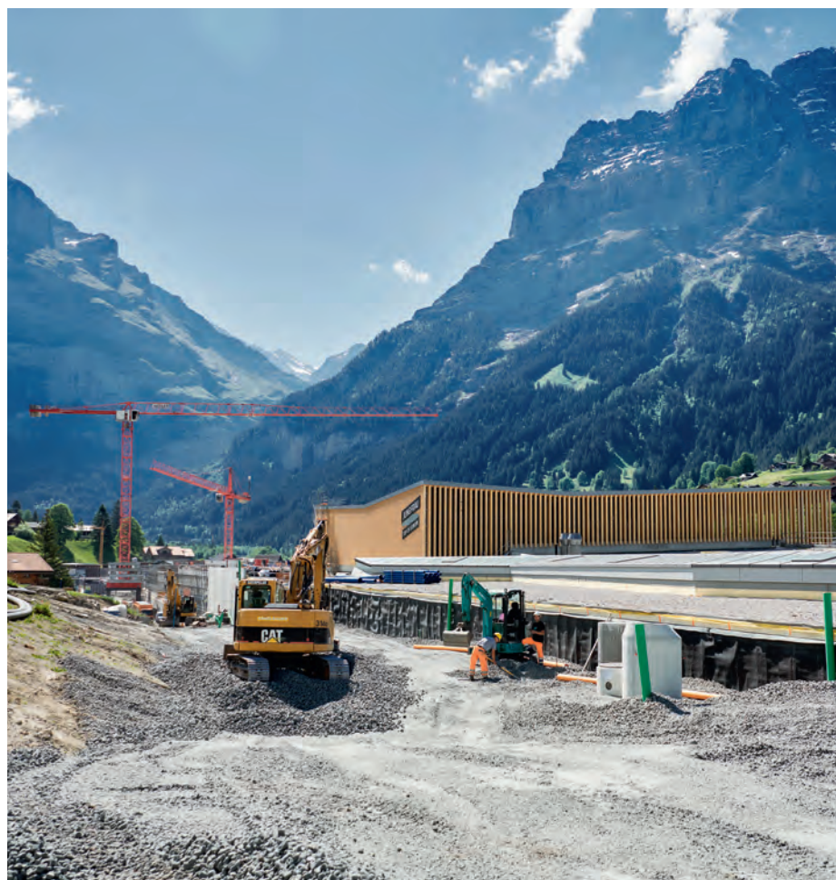
Hang in Bewegung: Um den Druck zu vermindern, sichern Arbeiter den neuen Terminal mit Schaumglas-Schotter.
