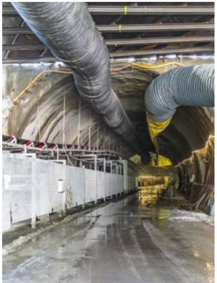
Eingang Zugangsstollen Nord: Ab hier kam die Tunnelbohrmaschine zum Einsatz. Links das Depot des Förderbands, das immer weiter ins Tunnelinnere ausgerollt wird.
