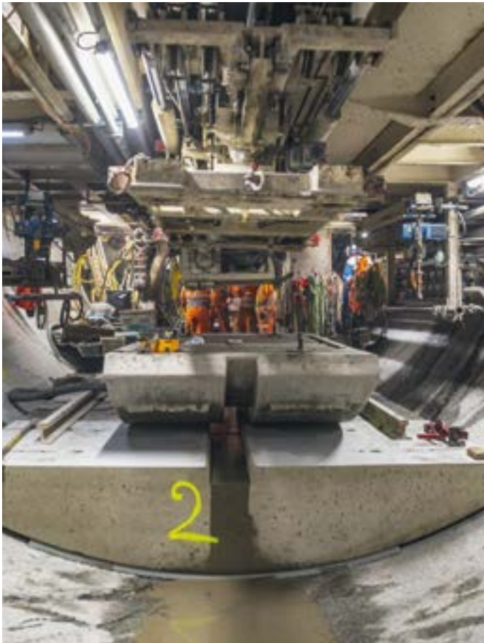
Präzisionsarbeit: Der ausgefräste Tunnelboden wird mit vorfabrizierten Tübbing gefüllt.
