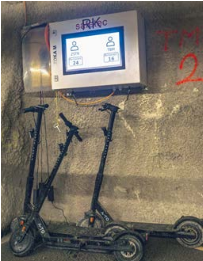
Sicherheit wird gross geschrieben: Der Bildschirm zeigt an, wie viele Personen im Tunnel und wie viele auf der TBM sind. Die Scooter sind für die Bauleitung und die Poliere.
