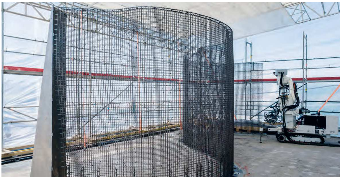
Revolution im Betonbau: Ein Roboter hat eine 3D-Gitterstruktur fabriziert, die als Schalung, aber auch als Armierung dient. Foto: Gramazio Kohler Research, ETH Zürich
