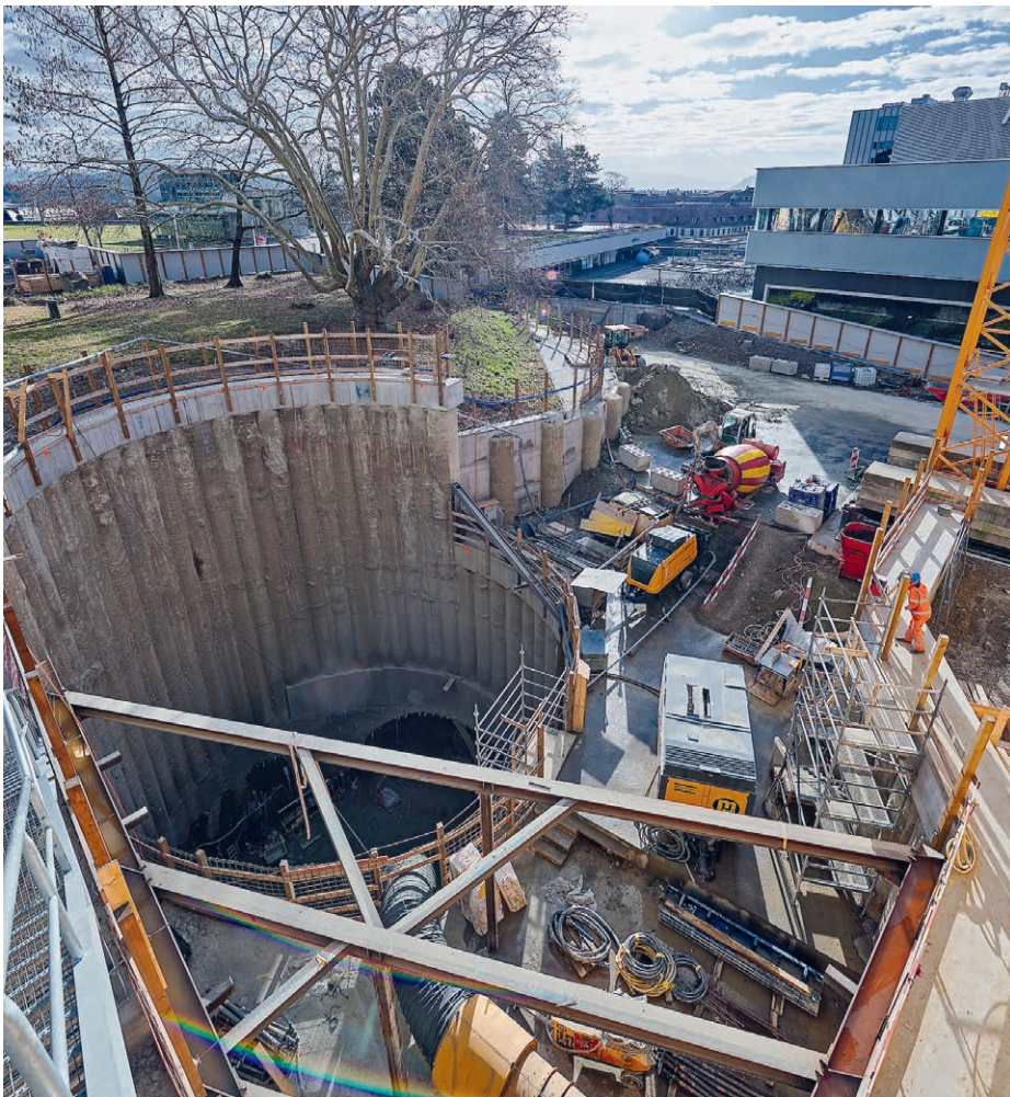
Nadelöhr Grosse Schanze: Über den 35 Meter tiefen Schacht wird der gesamte Aushub der neuen Unterführung abtransportiert werden.
