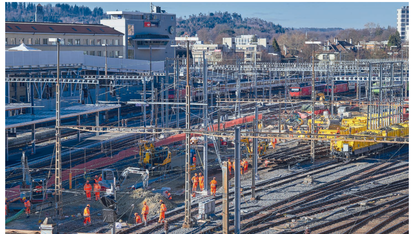
Im Westen wird ein Perron massiv verlängert, im Hintergrund (links) die Stahlplattform des Installationsplatzes Laupenstrasse.
