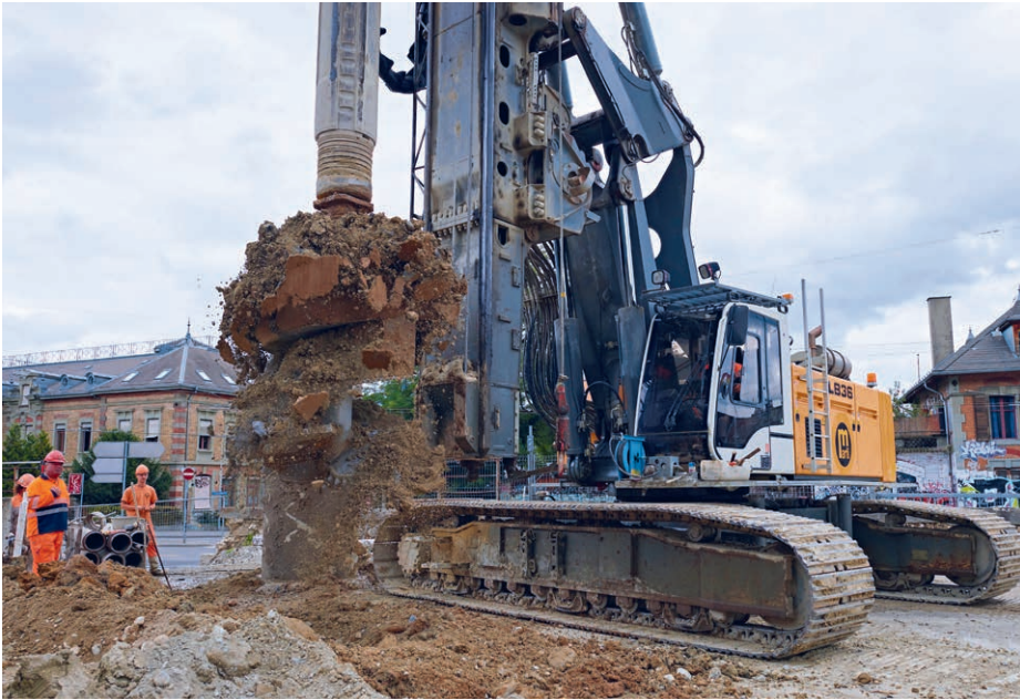
Deckelbau hinter der Reithalle: Mit dem Grossbohrer wird die Bohrpfehlwand gebaut. Foto Sam Bosshard/RBS
