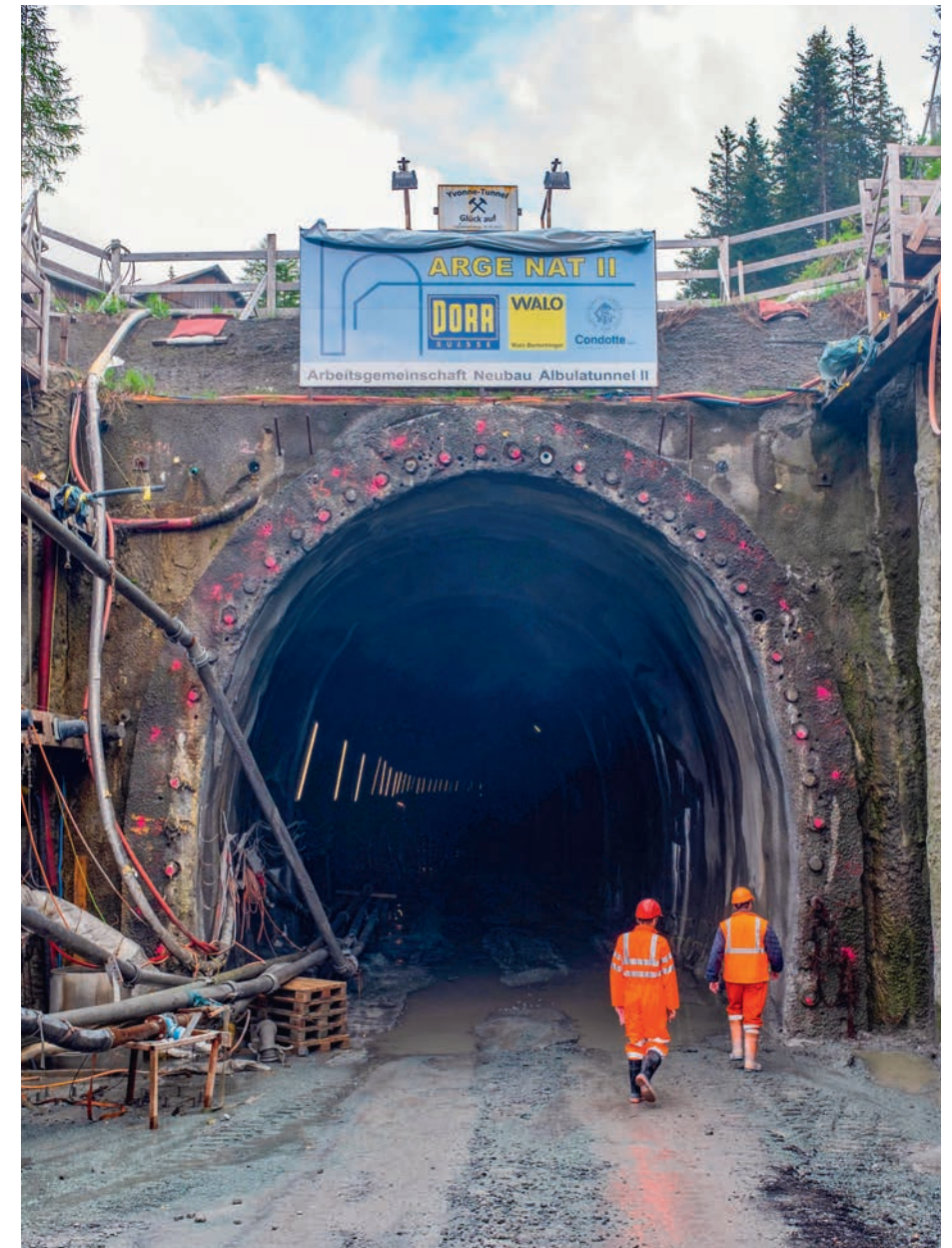
Neues Albula-Nordportal: Noch sind die Enden der Stahlrohre sichtbar, die für das sogenannte Rohrschirmverfahren in den Berg getrieben wurden.
