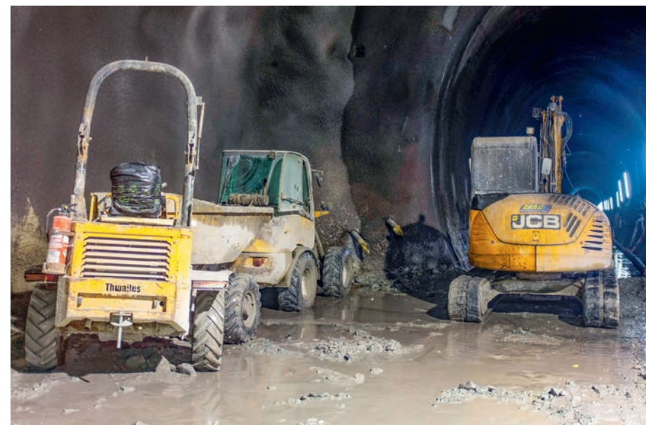
Arbeiten tief im Berg: Derzeit werden Schutt und Geröll beseitigt sowie die Tunnelsohle und das Gewölbe betoniert.
