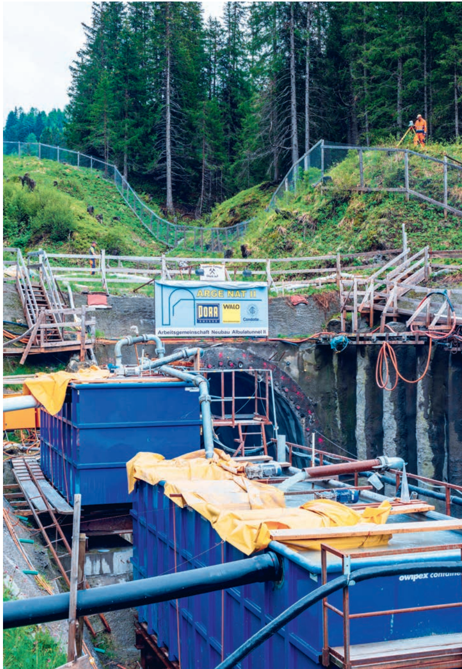
Aufwändige Abwasseraufbereitung: Dem verschmutzten Wasser wird Nitrit entzogen und der Säuregehalt (pH-Wert) mittels CO 2 wieder gesenkt.
