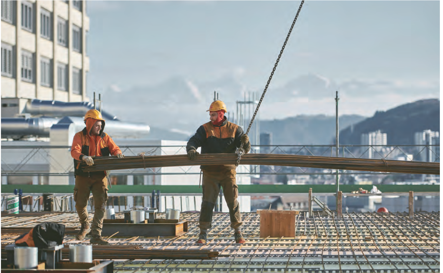
Baustelle mit Fernsicht: Für das neue Hauptgebäude des Inselspitals werden über 56 000 Kubikmeter Beton und 8200 Tonnen Armierungen verbaut.
