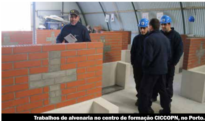
Trabalhos de alvenaria no centro de formação CICCOPN, no Porto.
