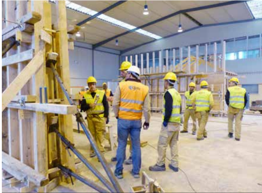
Trabalhos de cofragens no centro de formação Cenfic, em Lisboa.
