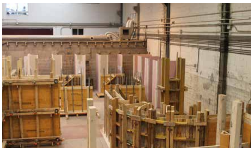
Os formandos fazem, por exemplo, complicados trabalhos de cofragem
