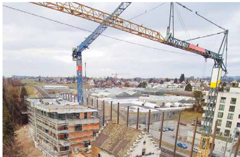
Sistema de informação Aliança construção (ISAB-SIAC) para uma construção civil melhor
