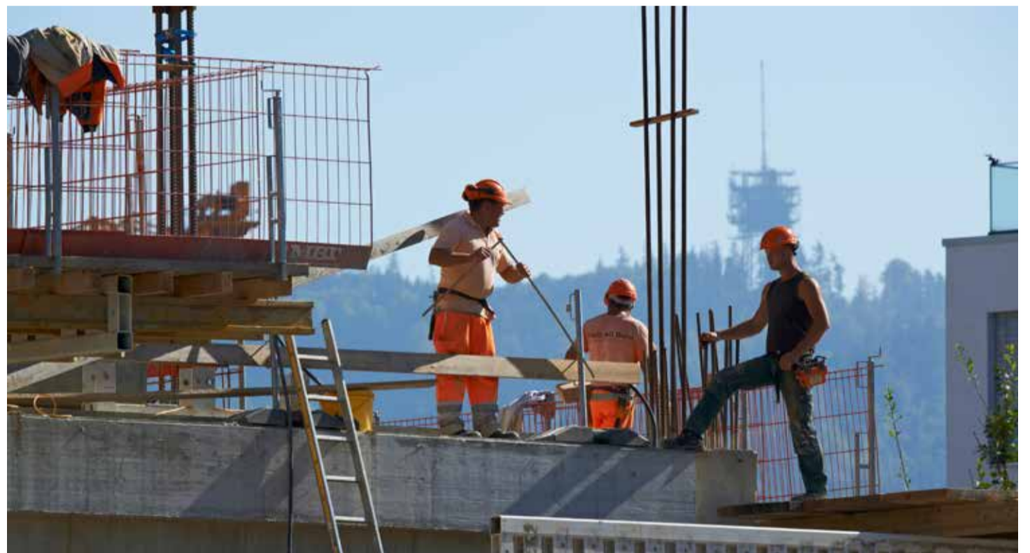
Na construção civil, há cada vez mais stress e pressão para o cumprimento de prazos
