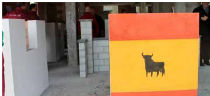
Trabalho de alvenaria em Espanha
