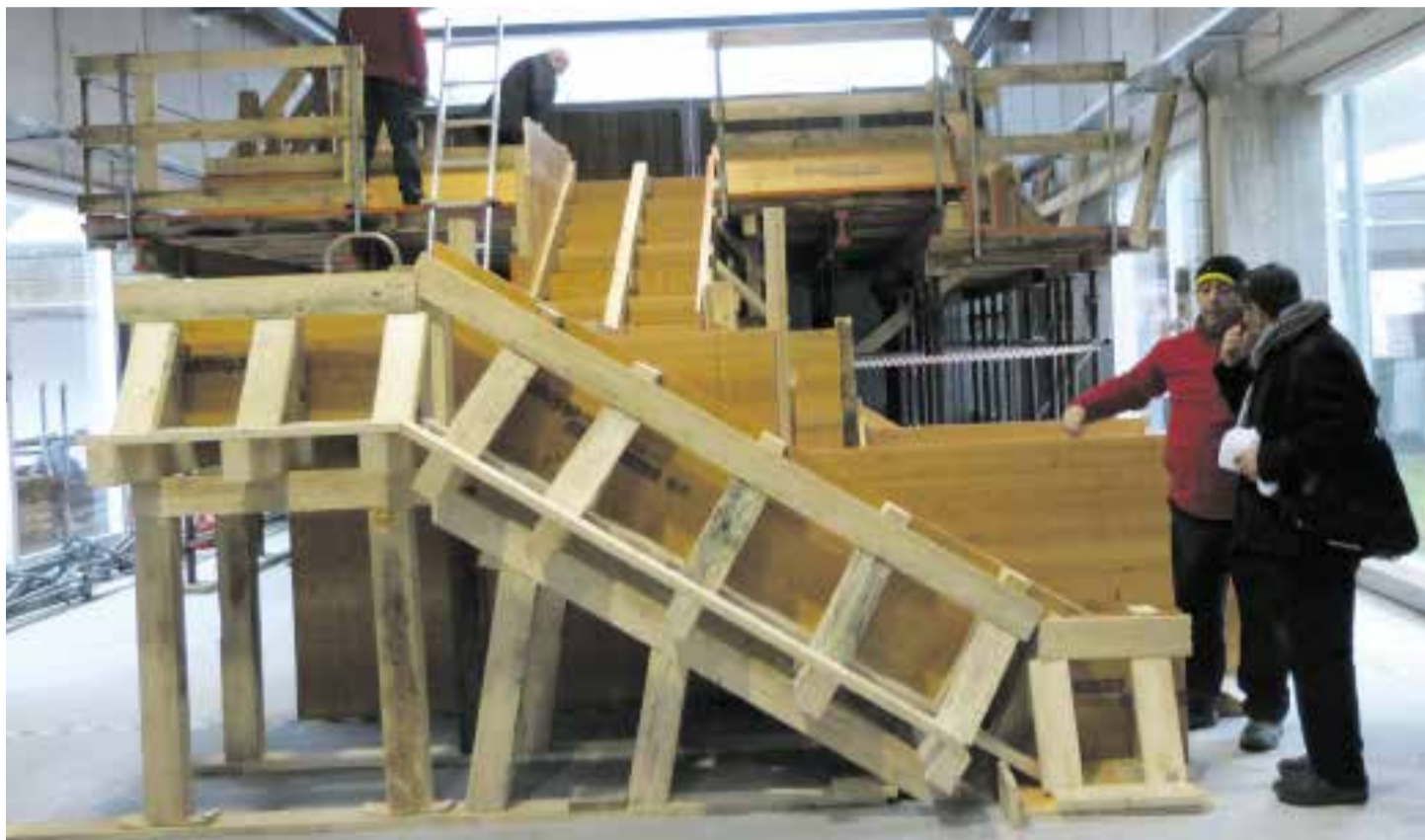
Nos cursos da construção em Portugal e Espanha, os trabalhadores aprendiam técnicas de confragem...
